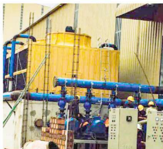
NHÀ MÁY TÔN HOA SEN PHÚ MỸ - BÀ RỊA VŨNG TÀU APC - S - 1500
