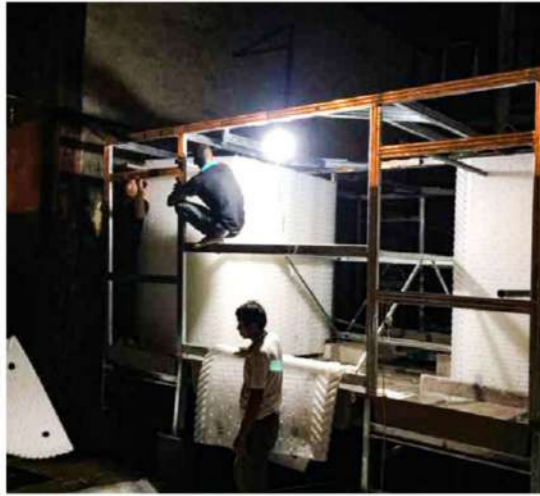
NHÀ MÁY THỰC PHẨM DOVICO - NINH BÌNH APC - S - PP300C2
