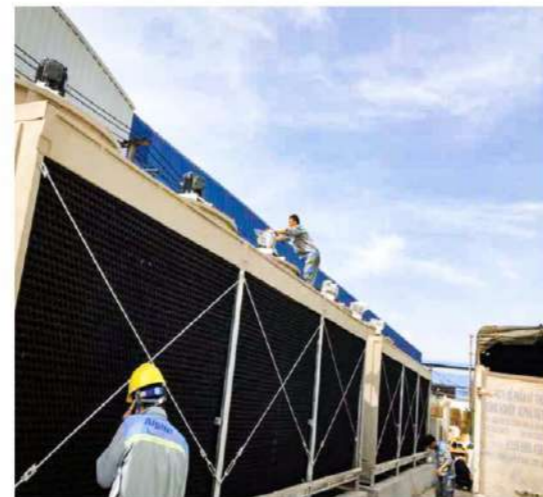
NHÀ MÁY DÂY CÁP ĐIỆN LS VINA - HẢI PHÒNG APC - S - 1800DC6 (300x6)
