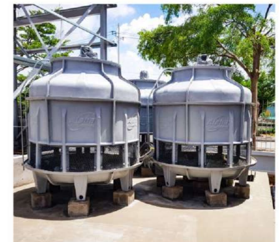
NHÀ MÁY AUSTDOOR NHƠN TRẠCH - ĐỒNG NAI
